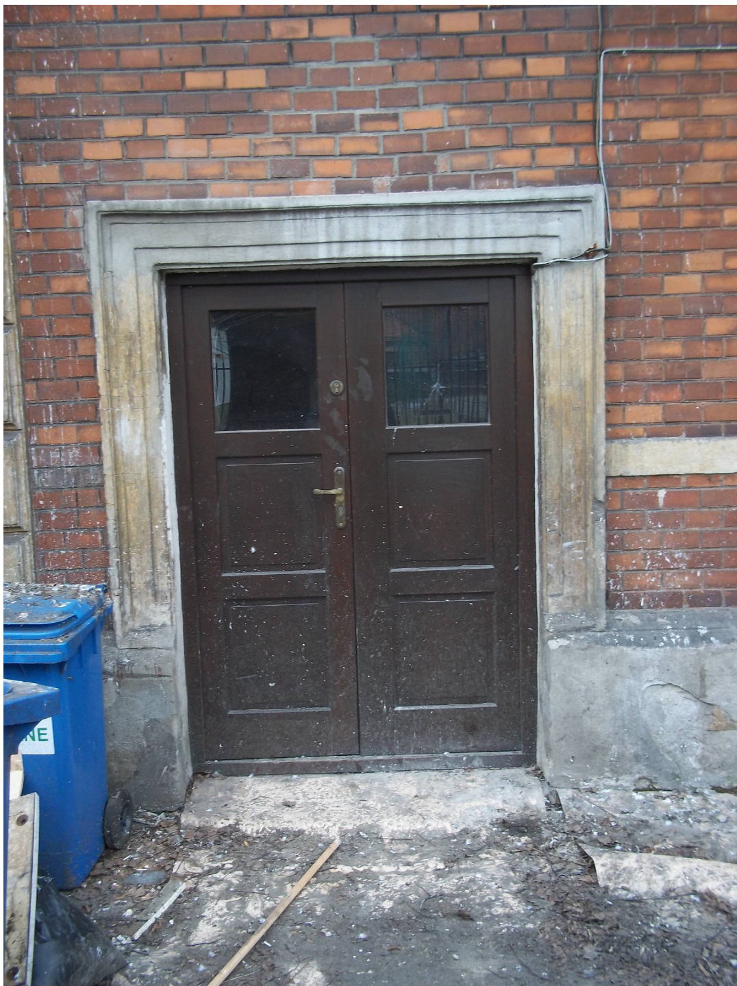
Fot.8. Kamienica przy ul. Piłsudskiego 29, widok elewacji od strony oficyny. Widoczne współczesne drzwi wejściowe do kamienicy. Drzwi kwalifikujące się do wymiany na nowe, drewniane, nawiązujące charakterem do całej kamienicy. Obramienie drzwi zniszczone, zabrudzone, z widocznymi pęknięciami.
