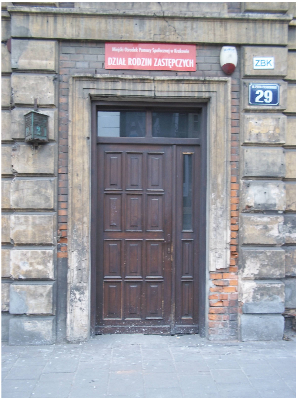
Fot.7. Kamienica przy ul. Piłsudskiego 29, widok elewacji od strony frontowej. Widoczne współczesne drzwi wejściowe do kamienicy. Drzwi frontowe współczesne. Poza framugą i nadświetlem kwalifikują się do wymiany na nowe, korespondujące z charakterem elewacji z końca wieku XIX. Obrazowanie wokół drzwi posiada znaczne ubytki; w dolnej partii odsłonięta cegła jest zmurszała, mocno zabrudzona, z licznymi ubytkami wstęgu. W ryzalicie liczne ubytki w partiach boniowania; dziury, spękania zaprawy, łaty cementowe. Nadproże pęknięte.
